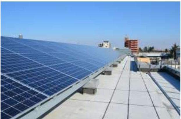
N棟の屋上にはソーラーパネルが設置されています。発電した電力で屋上緑化の自動散水装置を動かしています。
