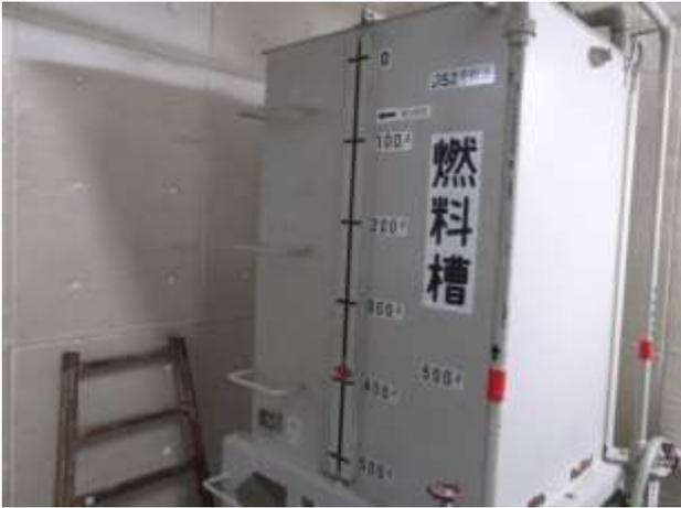
停電時に運転する非常用ディーゼル発電機の燃料タンクです。他にもポータブルのガソリン発電機、ガスボンベ発電機を備えています。
