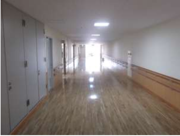
オープン型書架設置前の廊下
